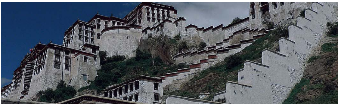
依山砌建，氣勢雄偉的布達拉宮，外牆漆上典型藏傳佛教風格的色彩。(廖南雁老師提供)
